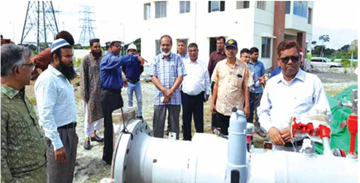
ভোলায় নির্মাণাধীন এনবিবিএল-এর ২২০ মেঃ ওঃ বিদ্যুৎ কেন্দ্রের আরএমএস পরিদর্শন
