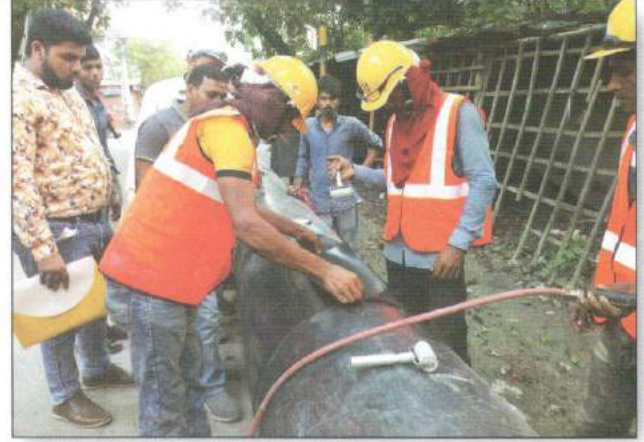
খুলনা ২২৫ ও ৮০০ মেঃঃঃ বিদ্যুৎ প্রান্তের গ্যাস সংযোগ প্রদানের লক্ষে লাইনপাইপ নির্মাণ কাজ
