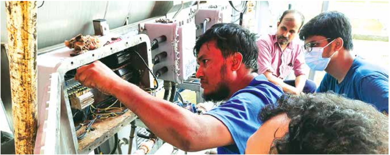
ভেড়ামারা সিসিপিপি আরএমএস এর ওয়াটার বাথ হিটারের মেরামত কার্যক্রম
