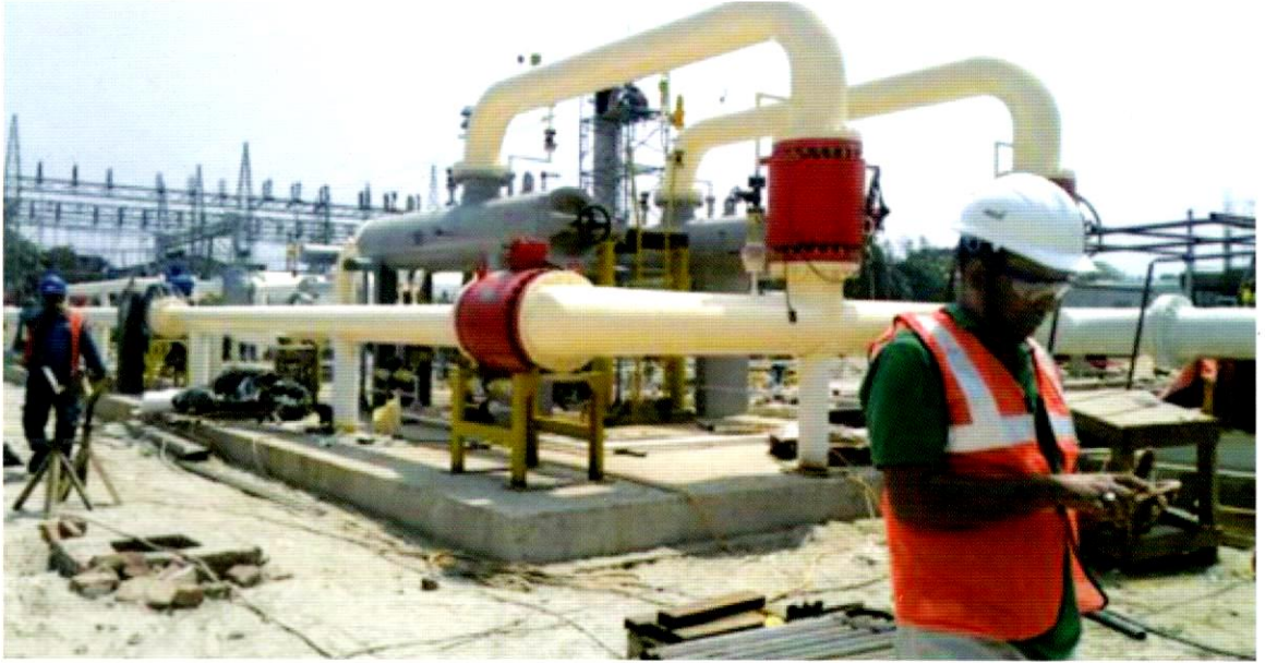
ভেড়ামারা ৩৬০ মেঃওঃ সিসিপিপি আরএমএস নির্মাণ কাজ চলমান
